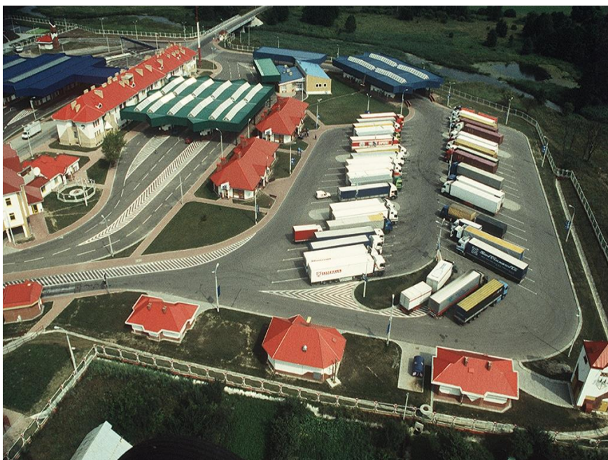
Nowoczesna infrastruktura drogowego przejścia granicznego
