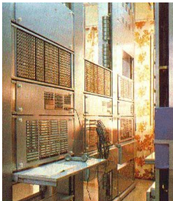
Fot. 2. Centrala telefoniczna PENTACONTA 1000 C.
