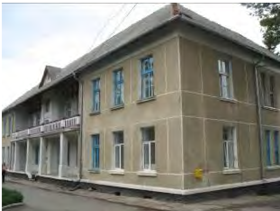
Budynek Stacji Gołębi Pocztowych w Buchaczu
