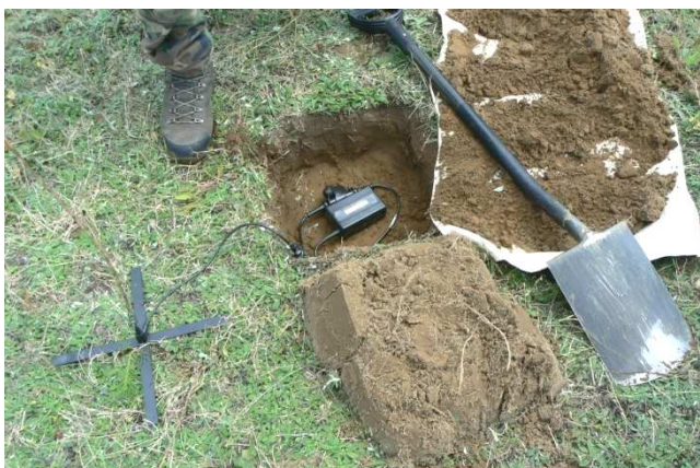
Zasypanie urządzeń i zagęszczenie ziemi
