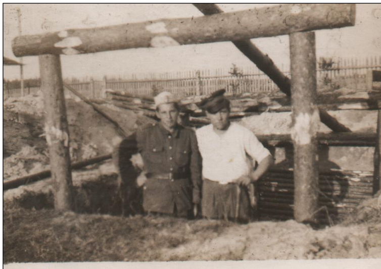
Budowa ziemianki – Masiewo 1946 r.
