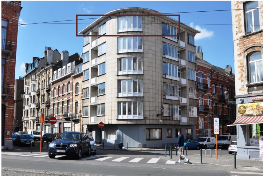
Fot. 16. Budynek, w którym przebywali podejrzani mężczyźni – Schaerbeek, północny dystrykt Brukseli
